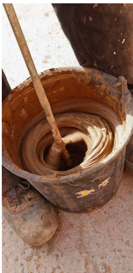
Het is belangrijk dat het mengen gebeurt in de juiste dosering gedurende voldoende lange tijd in een zuivere emmer.
